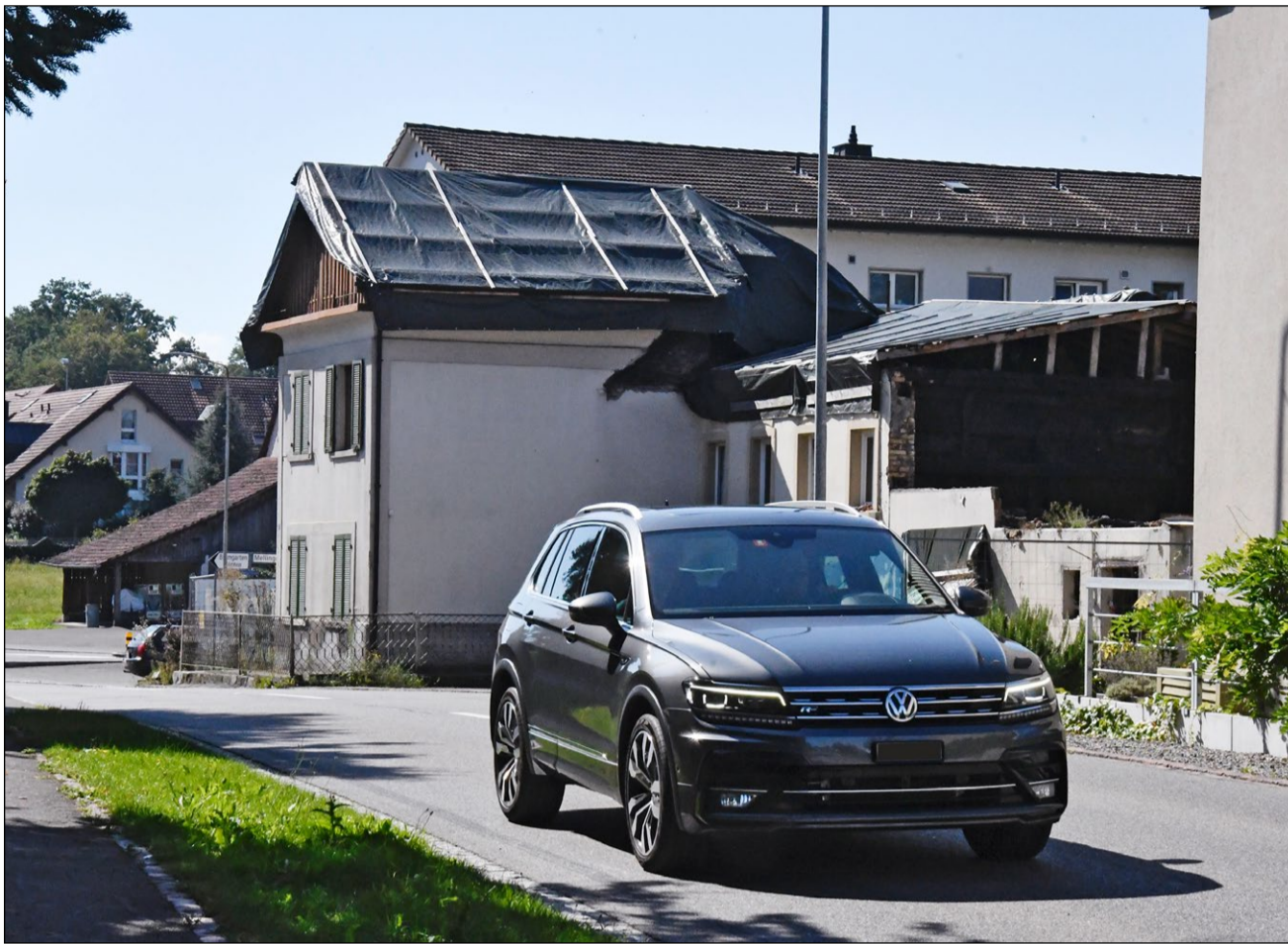
Vor dem Winter, mit Wind und Sturm, soll die notdürftig abgedeckte Brandruine abgebrochen werden. Foto: hhs
