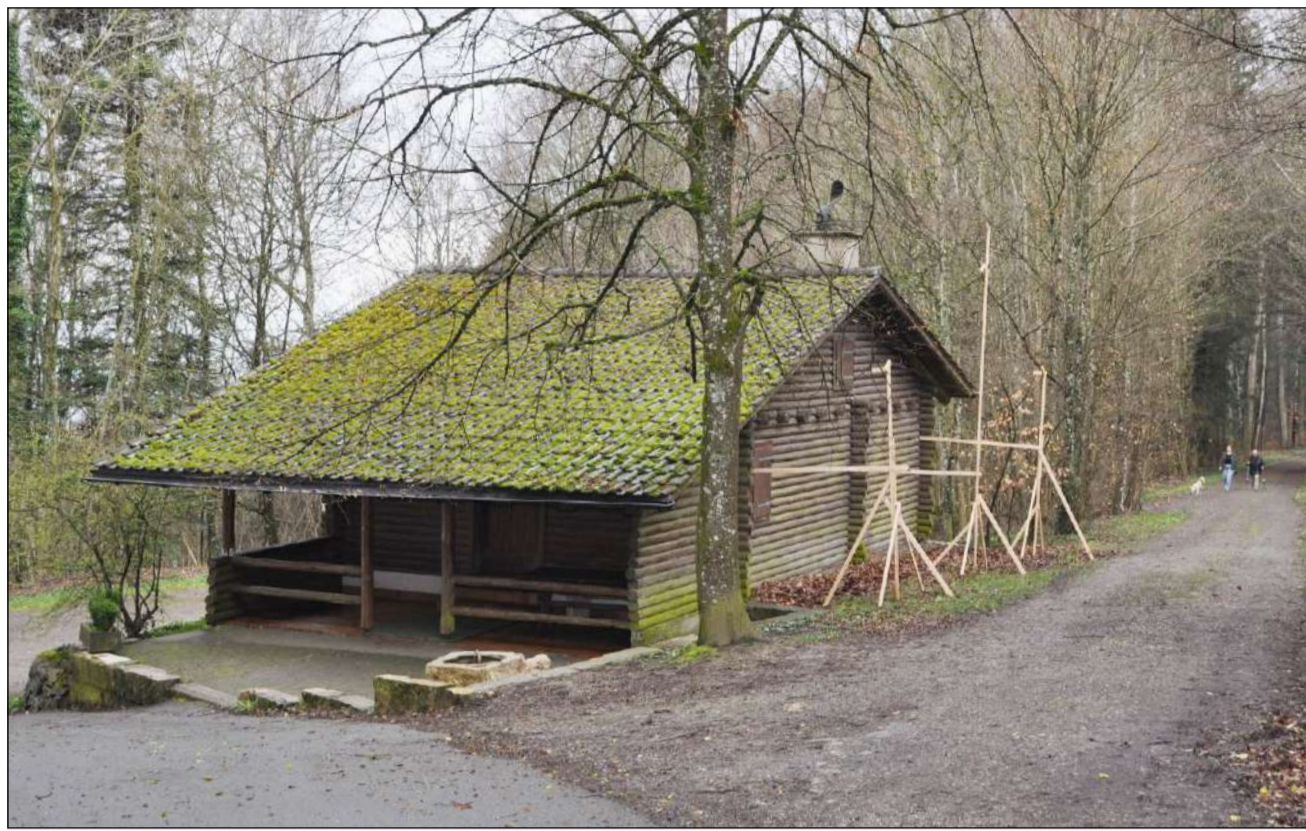
Die in die Jahre gekommene Waldhütte Staretschwil soll teilweise zurückgebaut werden. Dach und Erdgeschoss werden komplett erneuert. Wo die Bauprofile stehen, wird das EG um 1,74 auf rund 8,50 Meter verbreitert. Foto: ml
